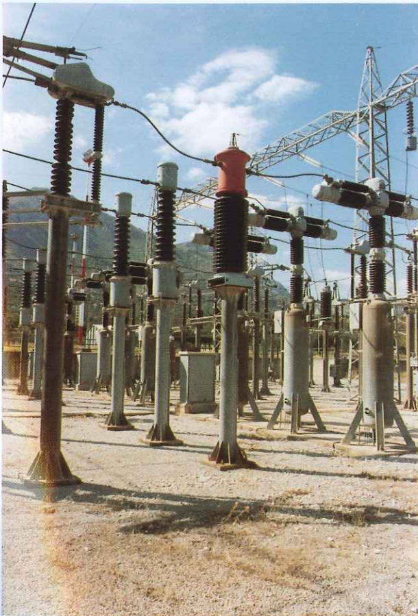
Ristrutturazione stazione elettrica Enel 220 kV PALERMO
